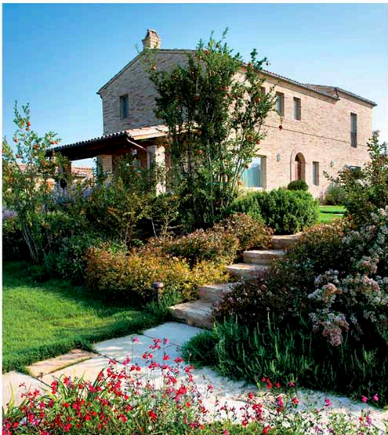
La scala in vecchi mattoni di recupero collega il piano della piscina con quello dell'abitazione.
